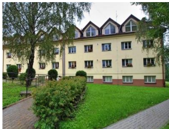
Budova pavilonu P1
