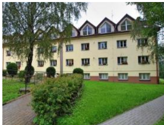
Budova pavilonu P1
